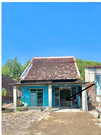
Gambar 2. Bentuk adaptasi dengan peninggian lantai
