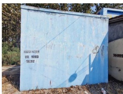
Gambar 3. Bangunan bak penampung air
