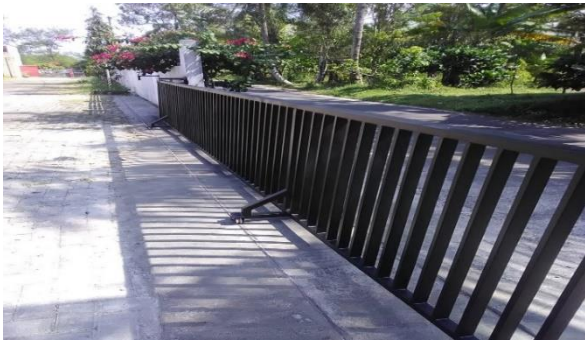
Gambar 8 Hasil Perbaikan Gerbang Perumahan Villa Permata
