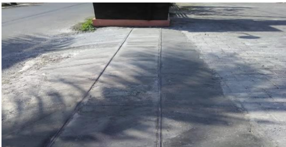
Gambar 5 Hasil perbaikan rel Perumahan Villa Permata Bawen
