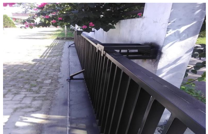
Gambar 7 Hasil Dempul dan Pengecatan Gerbang Perumahan Villa Permata Bawen
