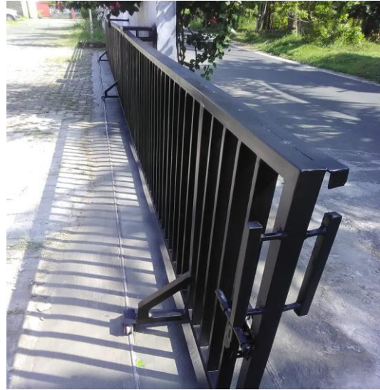
Gambar 6. Hasil penggantian roda gerbang Perumahan Villa Permata Bawen
