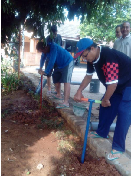
Gambar 5. Pengeboran tanah menggunakan alat khusus pembuat biopori
