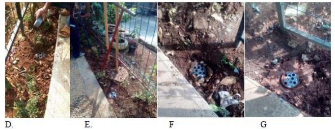
Gambar 8. Biopori pada Taman sisi Utara yang sudah jadi (D, E, F, G)
